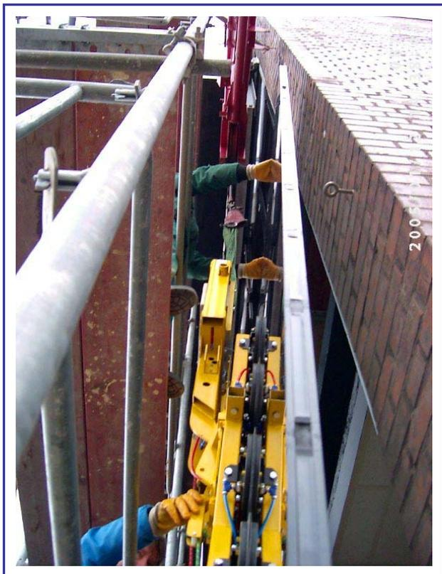
En l'espace de quelques minutes, le système mécanique de pivotement peut être remplacé par un dispositif hydraulique de pivotement.
